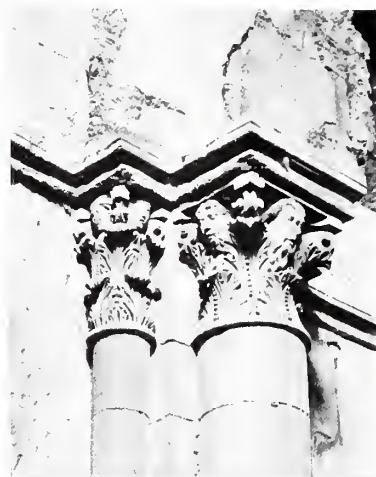
Fig. 25. - MESSINA - Chiesa di S. M. degli Alemanni. Capitelli di colonne incastrate nella parete laterale sinistra.
